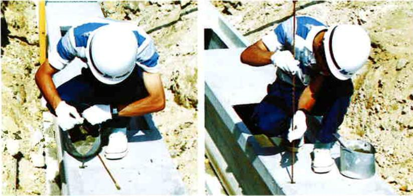
ほぼ液状(配合1:1)のモルタルを漏斗などにより目地部へ注入します。
