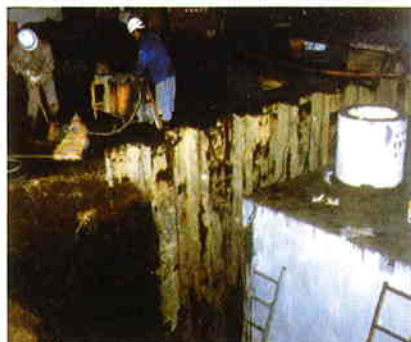
4 グラウト注入
