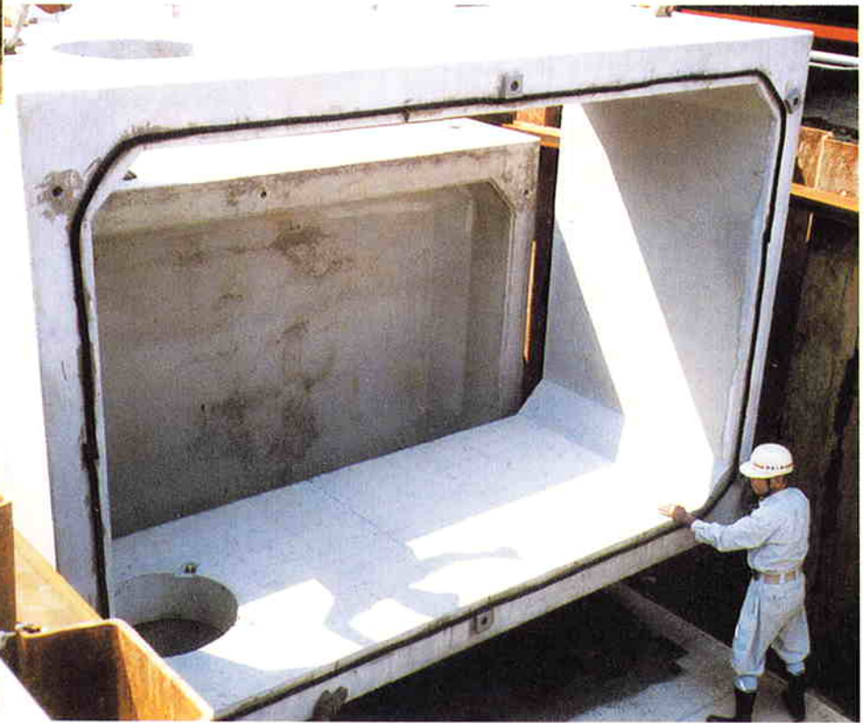
2 製品据付・組立
