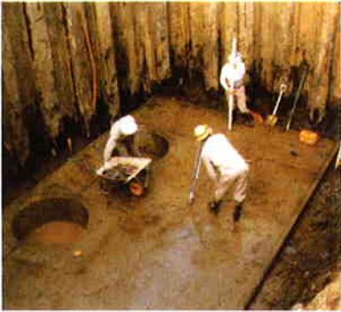
1 基礎ベースコンクリート状況
