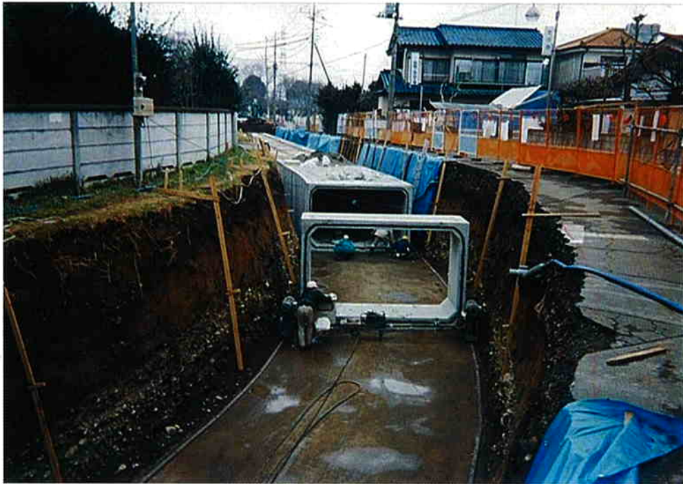
▲ 台車工法 (R施工)
