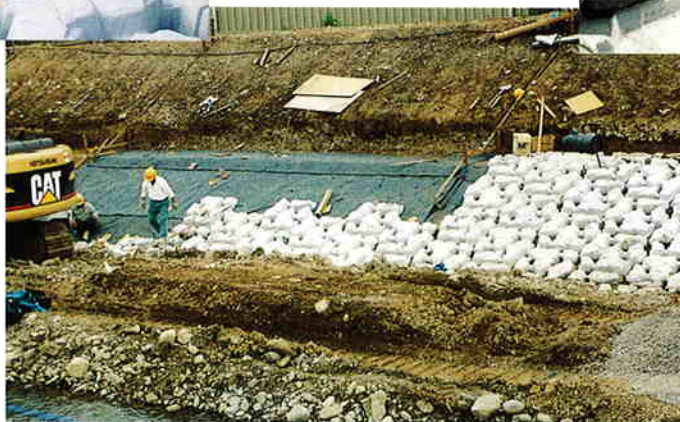
4. 法面製品据え付け CタイプI型
