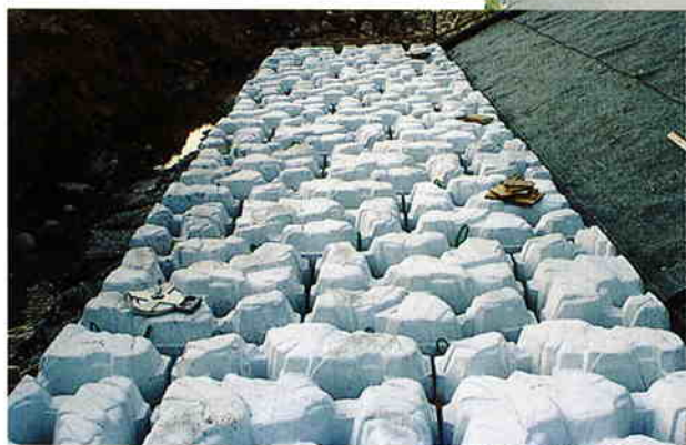
3. 河床製品据え付け CタイプII型
