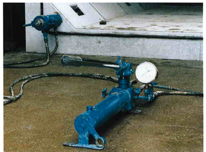
PC鋼棒による縦方向連絡の施工
