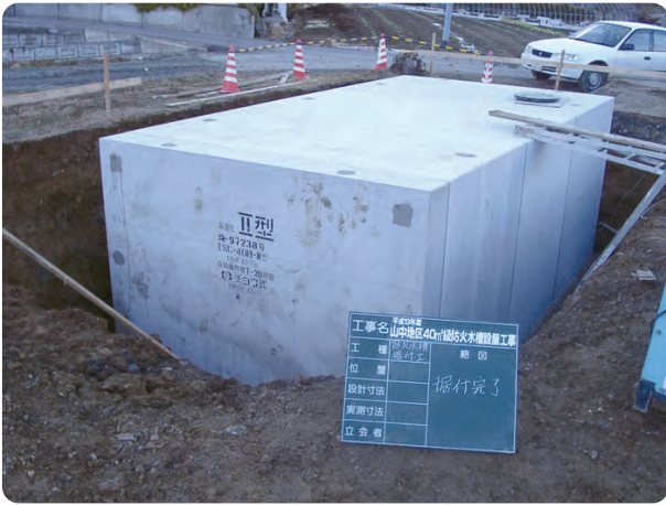
据付完了状況
