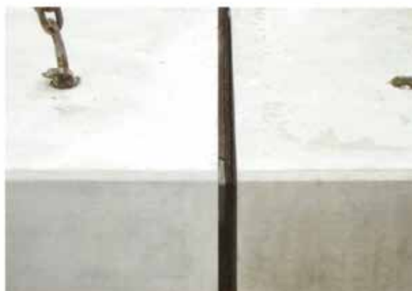
敷設後引き込み
