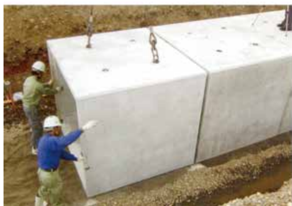
通常敷設状況
