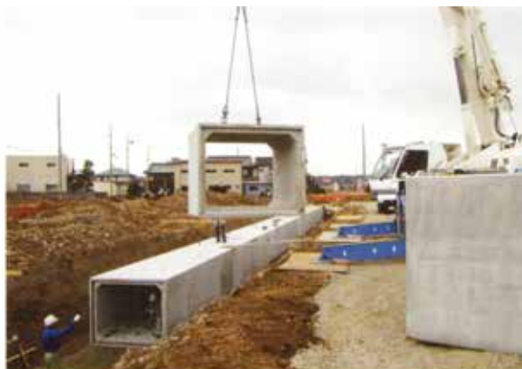
製品吊り込み
