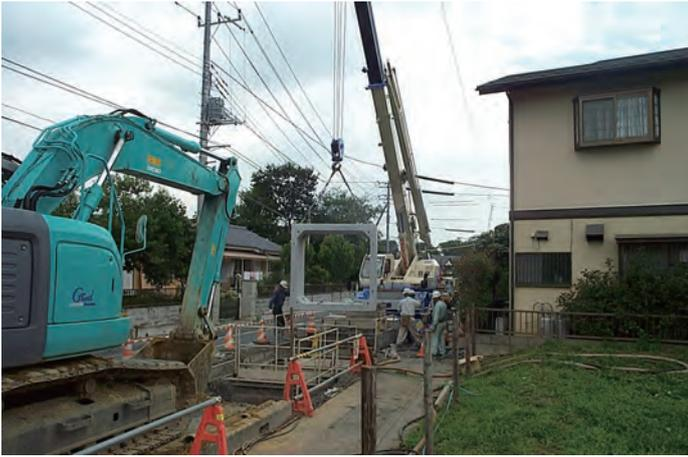
オープンシールド工法（NOS）は、従来の開削工法やシールド工法に代わる施工方法で、函渠（ボックスカルバート・U型カルバート）を地中に埋設する工法です。
