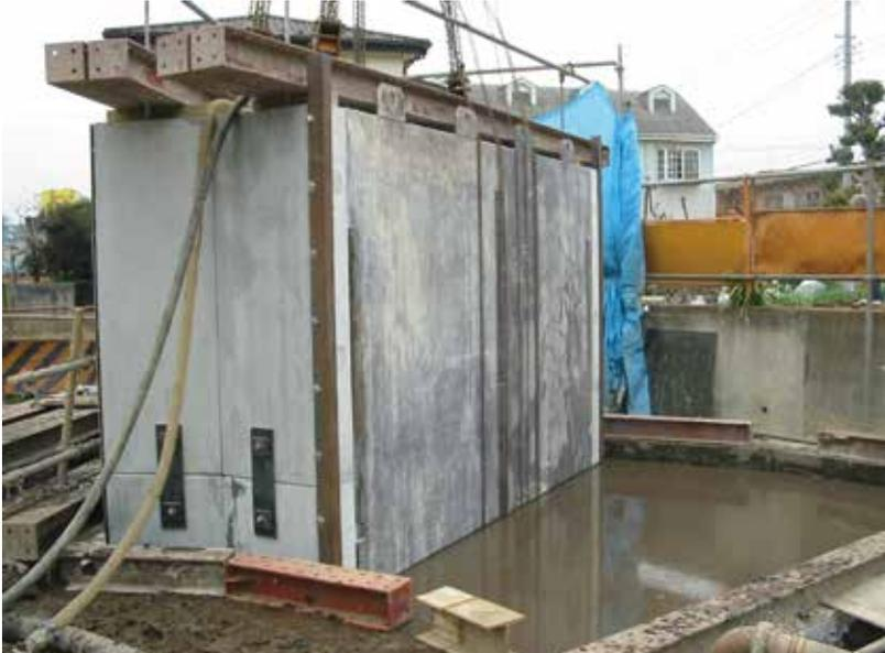
沈埋工法は、スペシャルスラリー（自硬性安定液）又はベントナイト安定液を壁面安定液としてトレンチを掘削し、一定の長さにあらかじめ連結したボックスカルバート・もしくは単体のボックスカルバートをトレンチの中に沈め所定位置に吊金具で固定し、スラリーを固化する事によって工事完了とする簡便で画期的な函埋設工法です。
