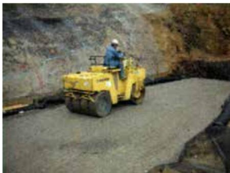
マットレス工法は、地盤改良における置換材をジオグリッドで包み込むことで、拘束効果により通常の置換工法に比べ、改良深さを減らすことができ、コスト縮減となる地盤改良工法です。
