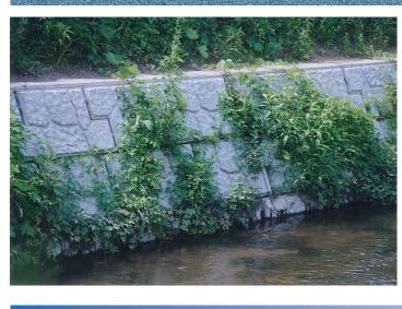
ビオグリーンは、環境保全型ブロック・中空型に属し、緑化復元に最適な護岸NETIS登録製品です。急傾斜用の護岸ブロック・大型積みブロックで、魚巣ブロック用・玉石積み用・高さ調整用・R曲線施工用タイプもあります。目地から植生できる構造で、河川改修工事・災害復旧工事・集落農道整備工事・親水水路整備工事などに採用されています。土木研究センターの護岸ブロックの水理特性値証明書を取得しています。
