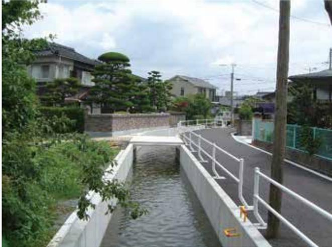
パワーUは、CY型パワーボックスカルバートと同じ外幅寸法になっているので、暗渠・蓋かけ水路という構成になる流路計画現場に最適な三面水路製品です。
