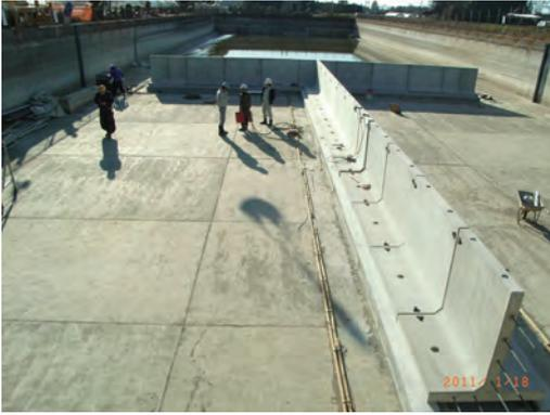
既存の掘込式 RC ファームポンドの容量を分量化し、メンテナンス作業（堆積土砂の撤去等）を向上させるための隔壁です。既存ファームポンドを供用したまま短期間での施行が可能です。
