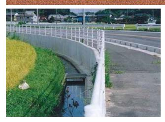
道路用地を100%利用できる直壁のL型擁壁です。 設計外力に対応した形状設定による力学的構成を呈し、 経済性・施工性に優れた軽量構造の道路用L型擁壁で す。
