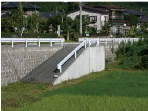
▲急勾配スロープ例
