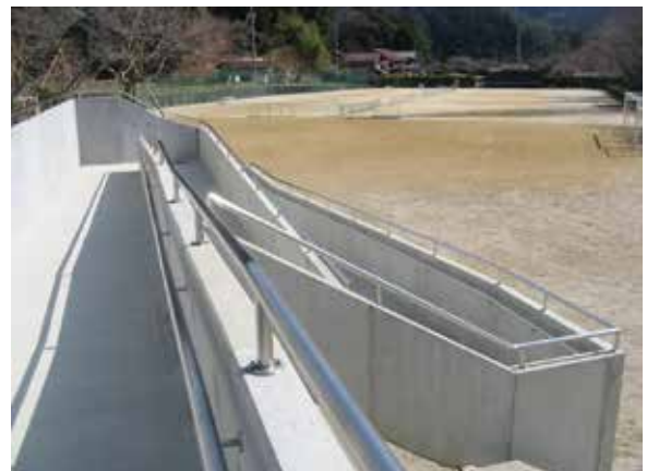
▲天端・側壁に手すり取付例
